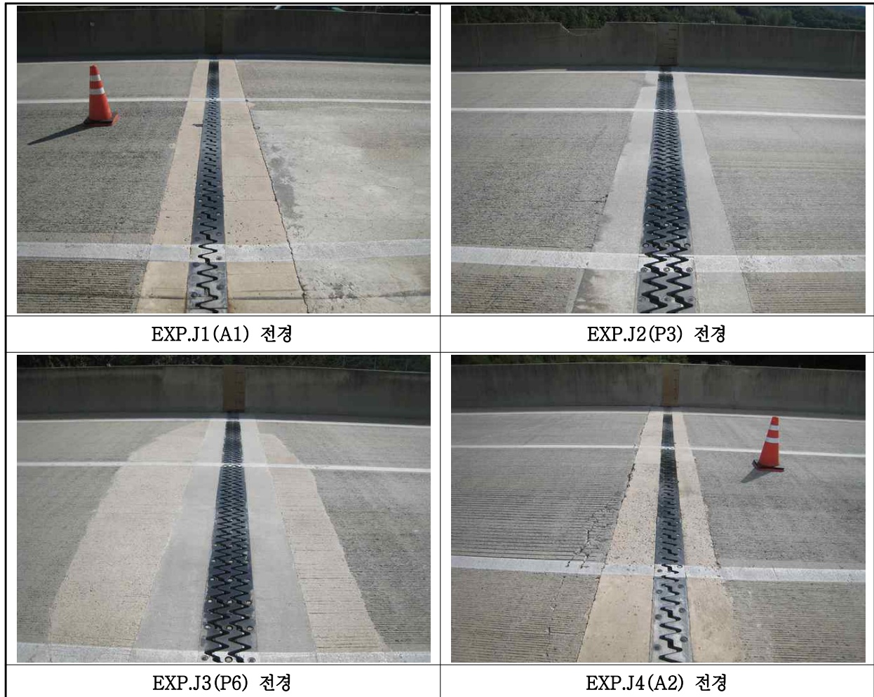
【사진 8.3.16】 신축이음장치 전경
