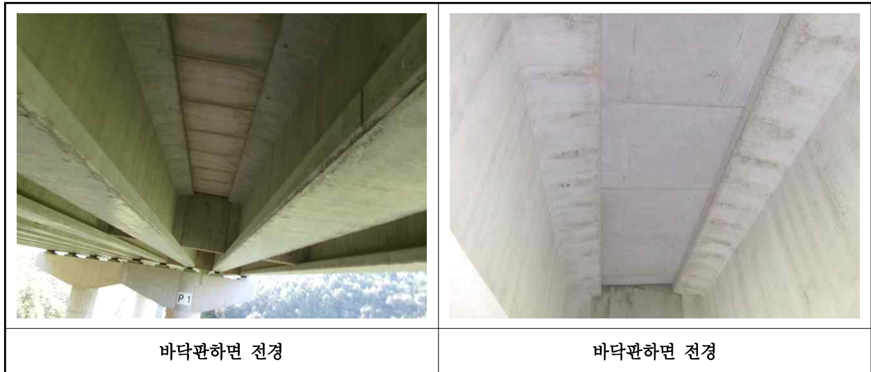
【사진 8.3.27】 바닥판하면 전경
