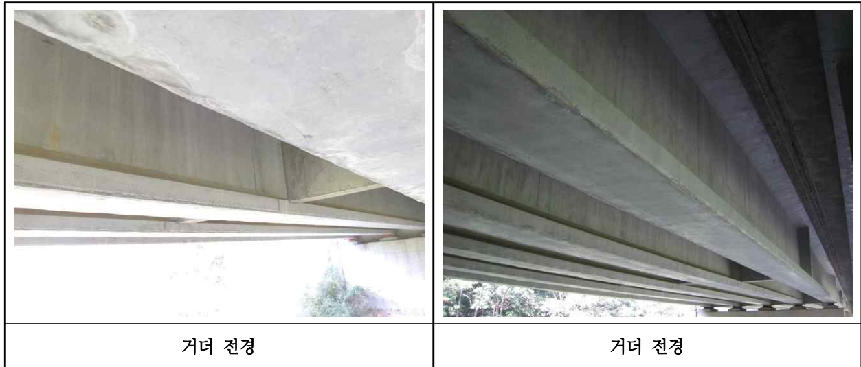
【사진 8.3.29】 거더 전경
