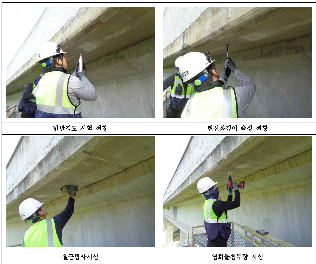
【사진 8.4.1】 콘크리트 내구성조사 현황
