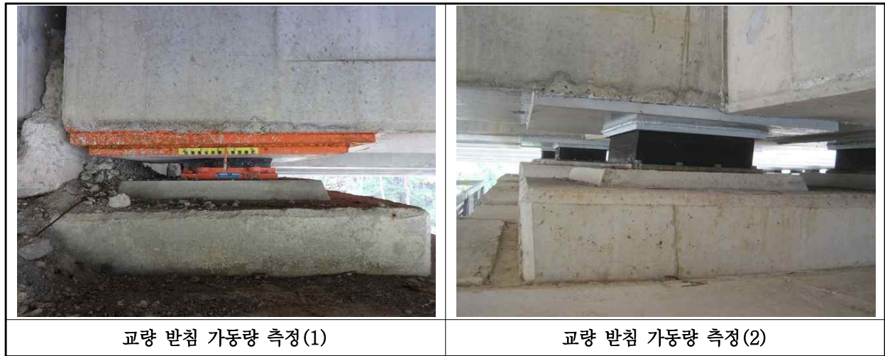
【사진 8.3.40】 교량받침 이동량 측정
