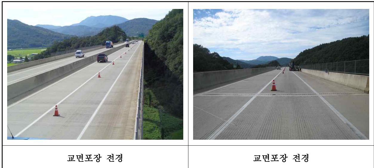
【사진 8.3.19】 교면포장 전경
