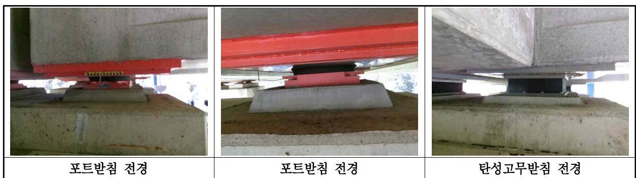
【사진 8.3.12】 교량받침 전경
