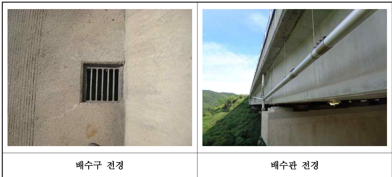
【사진 8.3.21】 배수시설 전경
