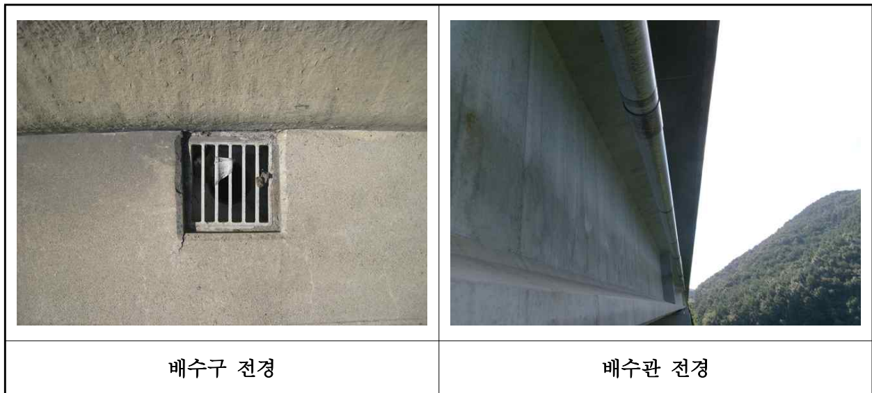
【사진 8.3.46】 배수시설 전경
