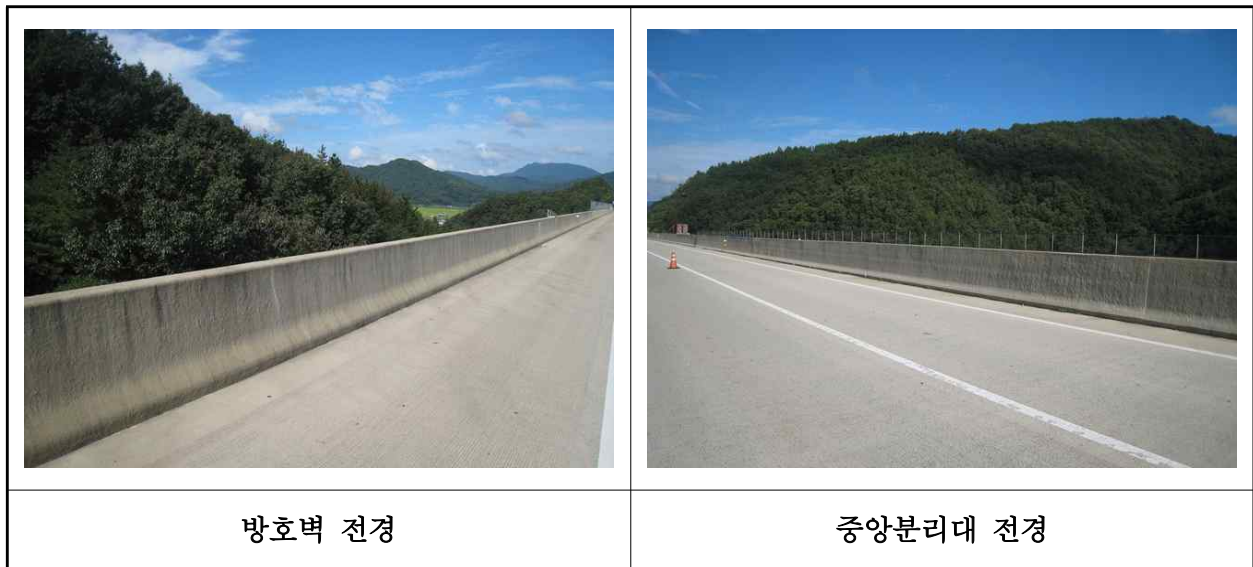
【사진 8.3.48】 방호벽 및 중앙분리대 전경
