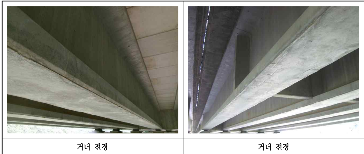
【사진 8.3.4】 거더 전경
