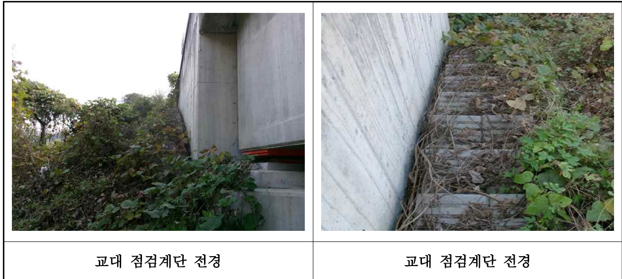
【사진 8.3.25】 교량 점검시설 전경
