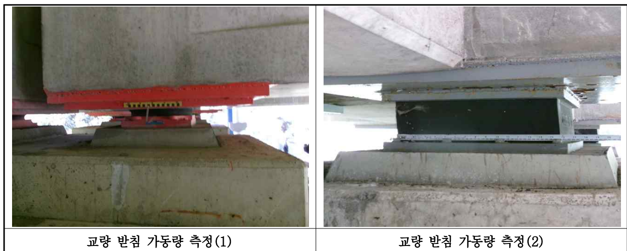
【사진 8.3.15】 교량받침 이동량 측정
