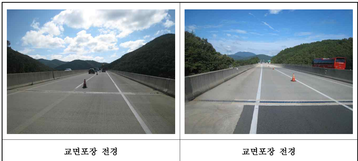
【사진 8.3.44】 교면포장 전경
